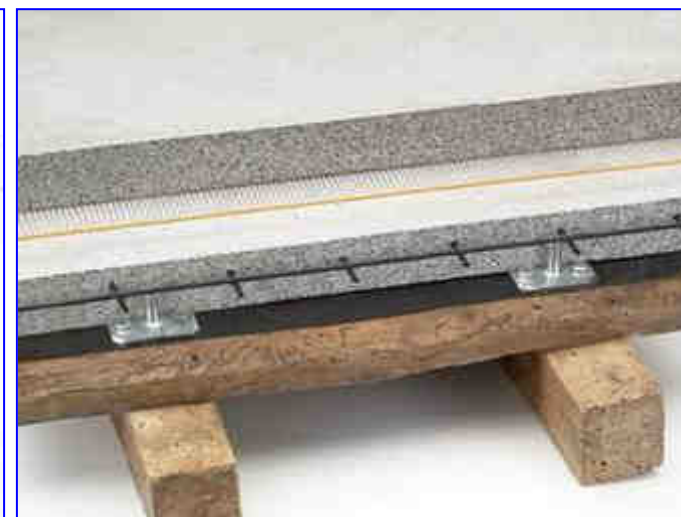
11 Plancher en bois massif avec chape en ciment et plafond suspendu (a)
