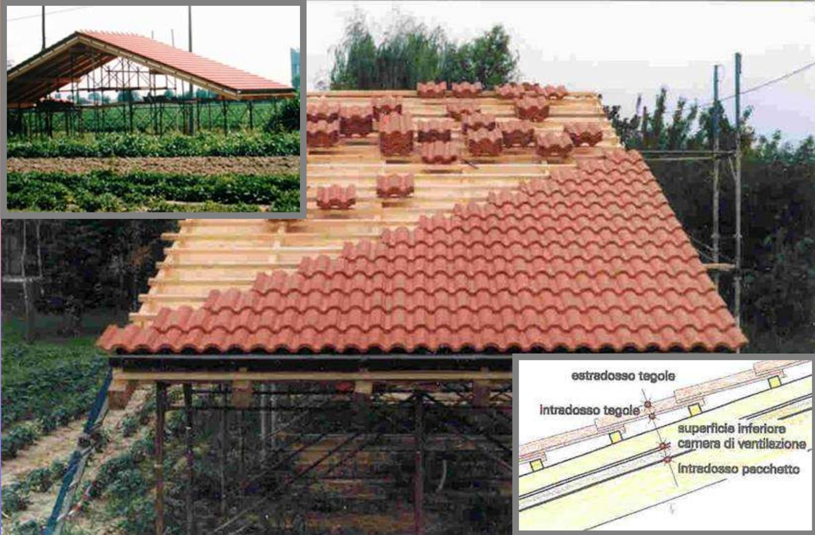
Copertura sperimentale in scala reale in ambiente reale, a due falde ventilate con esposizione nord e sud – Mirano - VE
