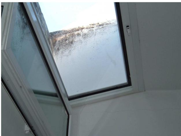
*Muffa su ponte termico tra finestra e controfinestra. L'aria che oltrepassa la controfinestra si raffredda a contatto col vetro esterno e deposita condensa su di esso e sul muro*
