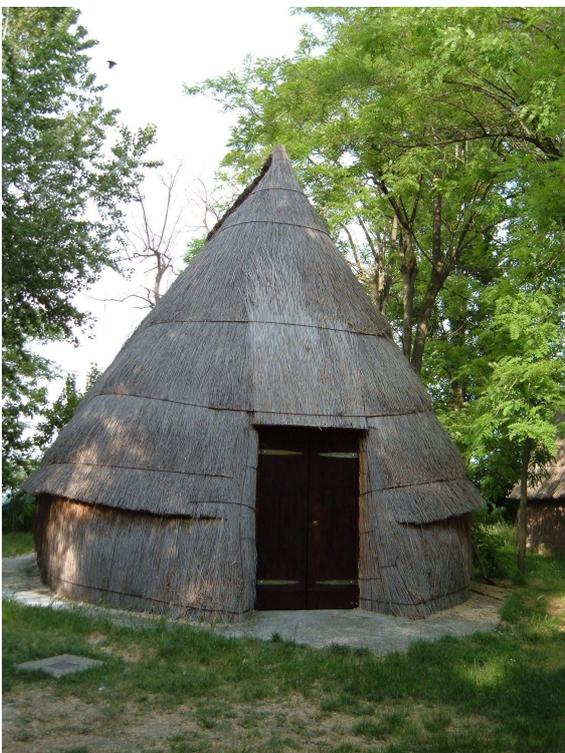
*I "casoni" di Caorle (Ve), costruzioni in cui pareti esterne e coperture erano interamente tamponate con canne palustri. Forse un tempo "respiravano", scambiando attivamente anche vapore con l'esterno. Oggi sono accuratamente impermeabilizzati per tenere l'acqua, ed anche per il vapore l'attraversamento di diversi strati costruttivi risulta difficoltoso*
