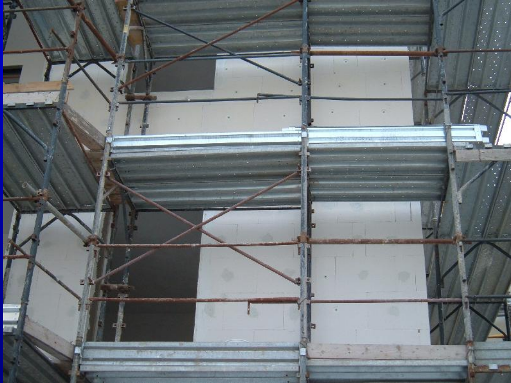
Sistema di isolamento termico a cappotto
