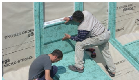
Fasi di installazione del sistema su rivestimento con pendenza variabile.
